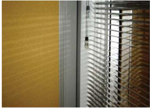
Figura 3 – Fresta entre divisória e alvenaria
